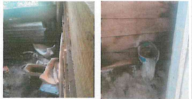
Foto 2: Sustitución de inodoros y accesorios de inodoros (Contra llave, tubos de abasto etc.)
