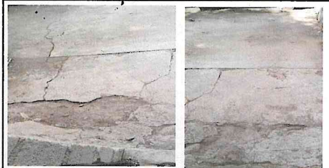
Foto 6: Reparación de piso torta de concreto.
