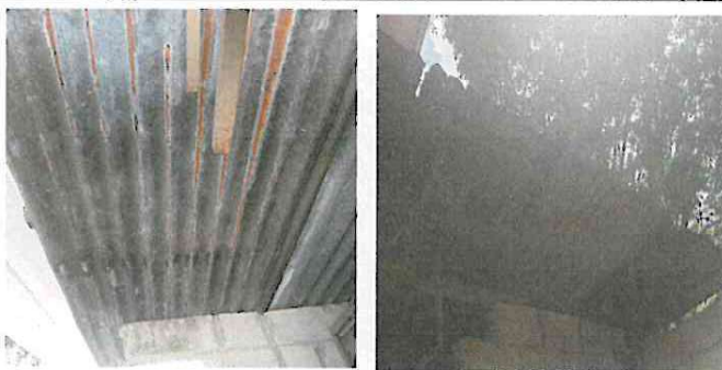
Foto 5. sustitución de lamina (acanalada o duralita) por lamina troquelada.
