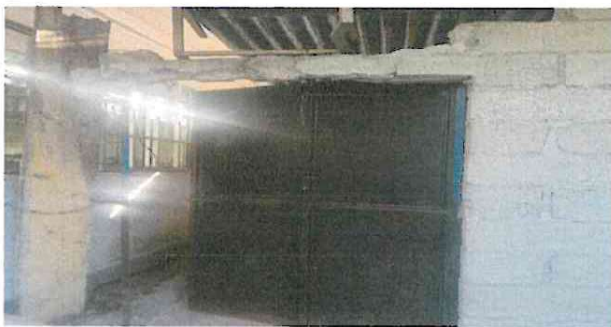
Foto 3: Sustitución de puertas en servicios sanitarios
